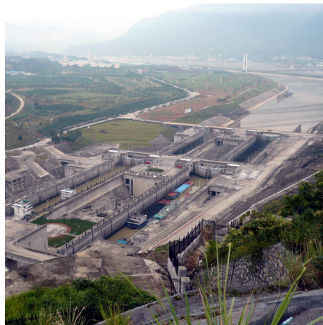
Slika 5: Zapornice ob jezu
